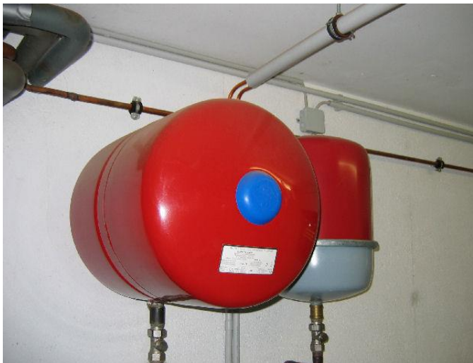
Abb.1: Ausdehnungsgefäß Heizung
