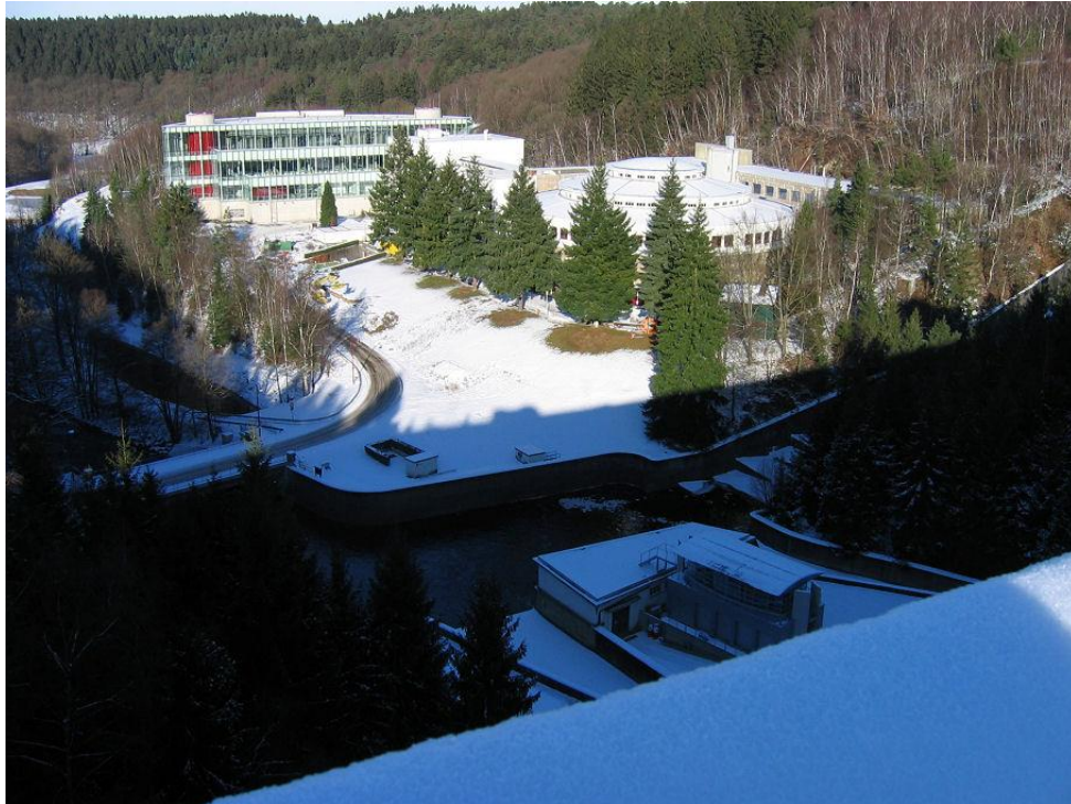
Abb.1: Wasserkraftwerk Wesertalsperre Eupen
